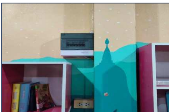
มีการติดตั้งอุปกรณ์ป้องกันไฟรั่วในอาคารเรียน
