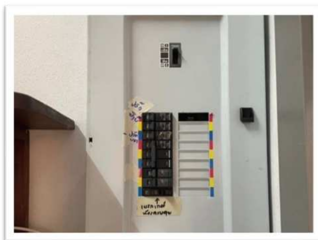
ติดตั้งอุปกรณ์ป้องกันไฟรั่ว
