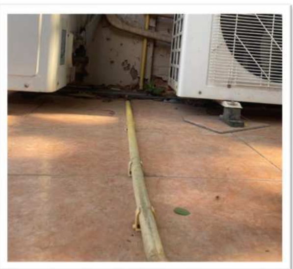
ติดตั้งสายดิน
