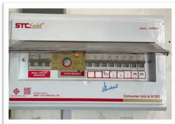
ติดตั้งอุปกรณ์ป้องกันไฟดูด
