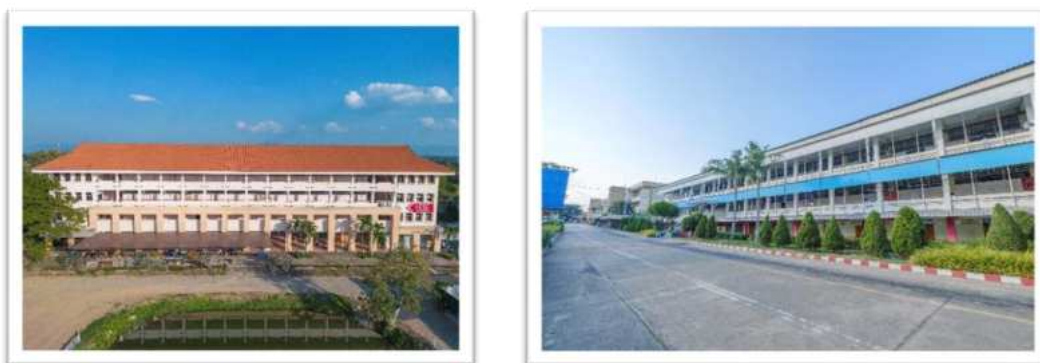
อาคารเรียน ภายในโรงเรียน
